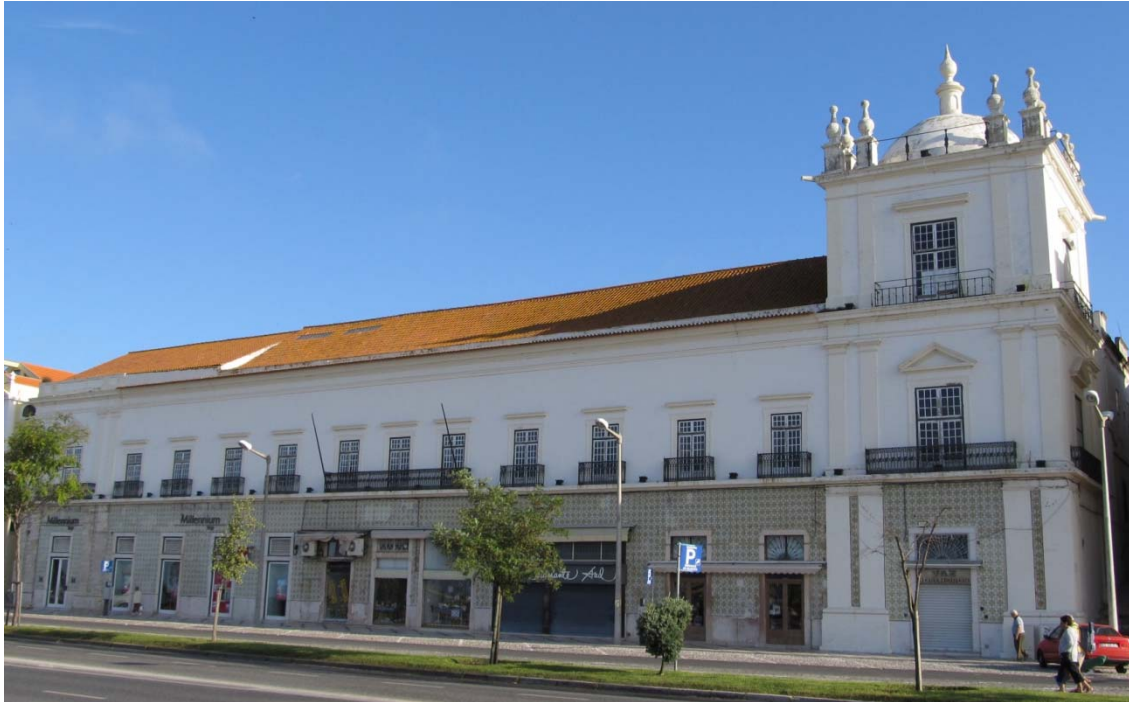
Fig. 1 – Fachada da Casa do Paço vista do lado do rio Mondego (Rua 5 de Outubro)
