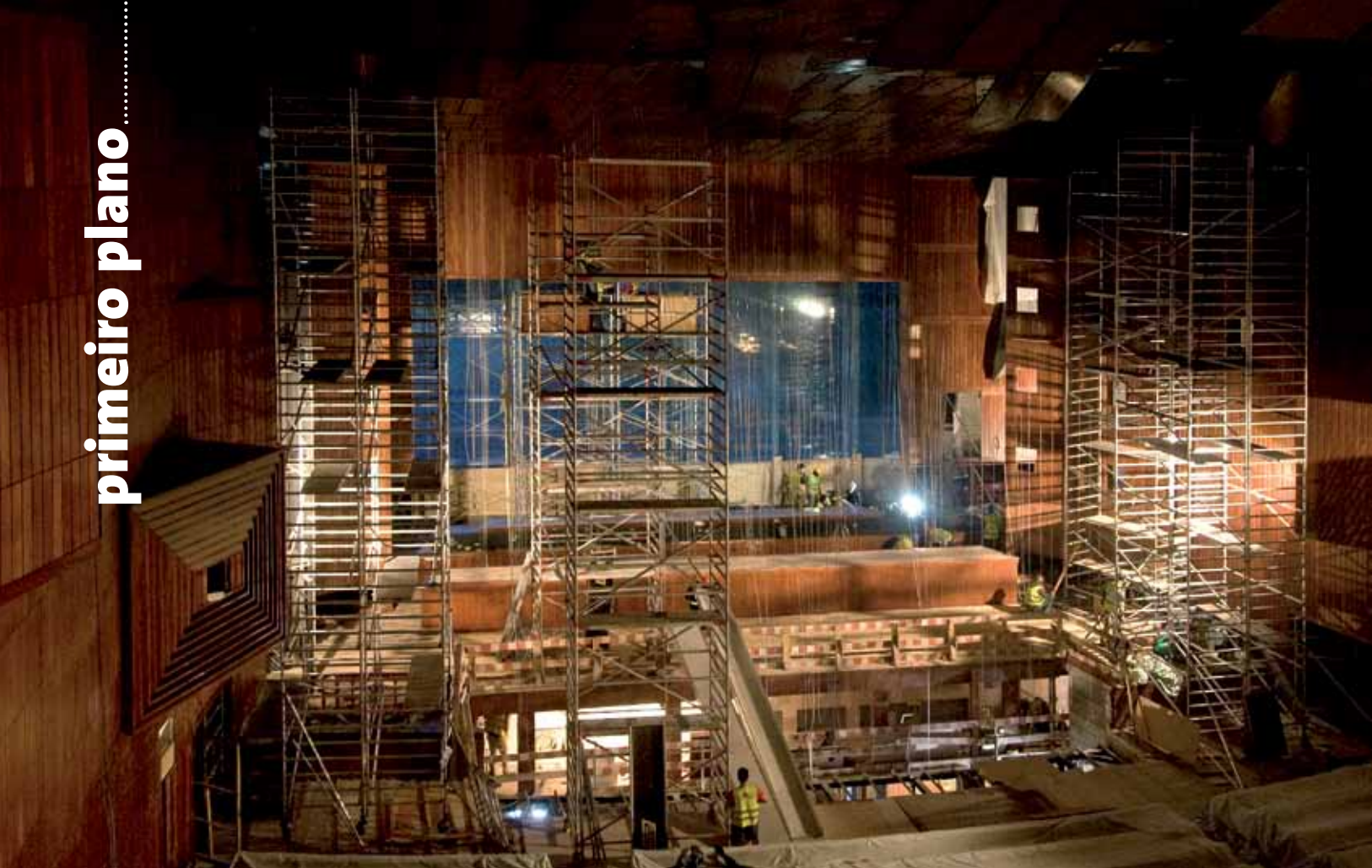
Aspetto geral das obras do Grande Auditório © Márcia Lessa
