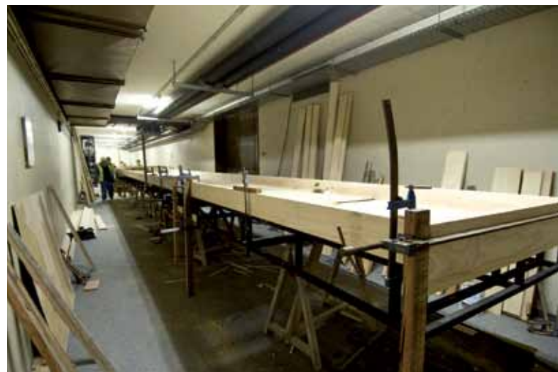
Construção de um troço da canópia © Márcia Lessa
