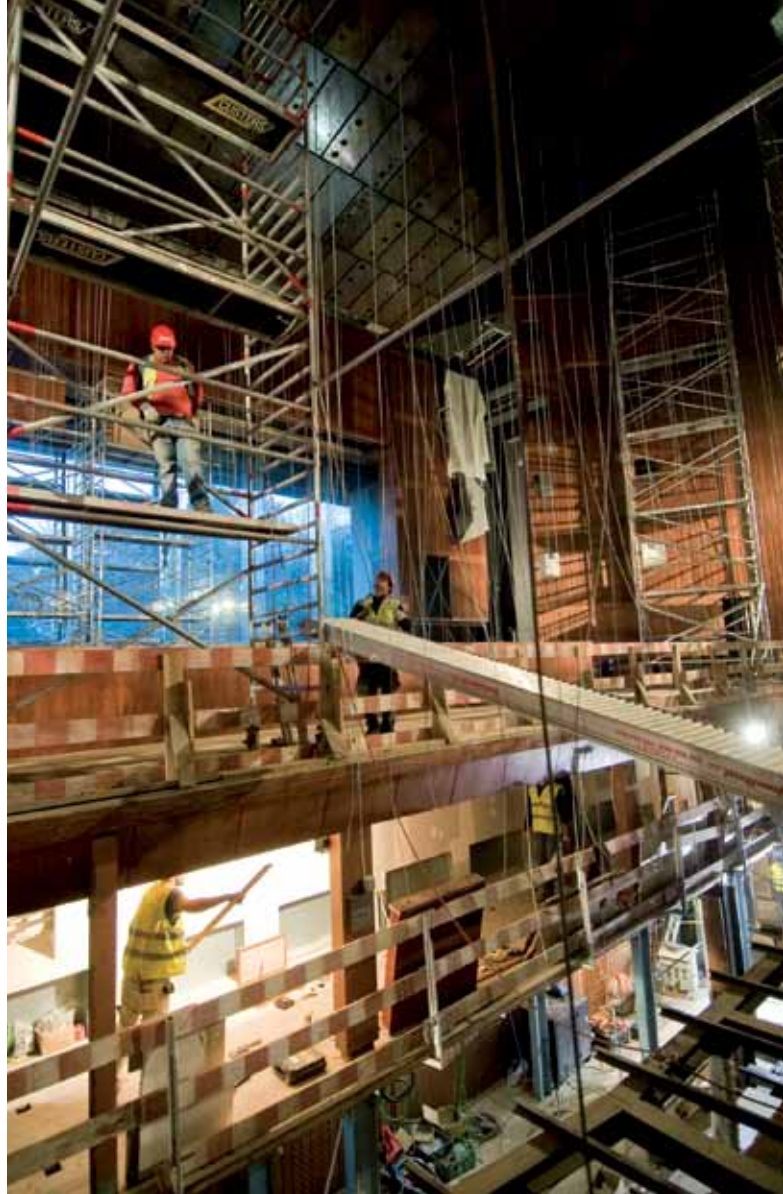
Construção dos elevadores de palco © Mária Lessa
