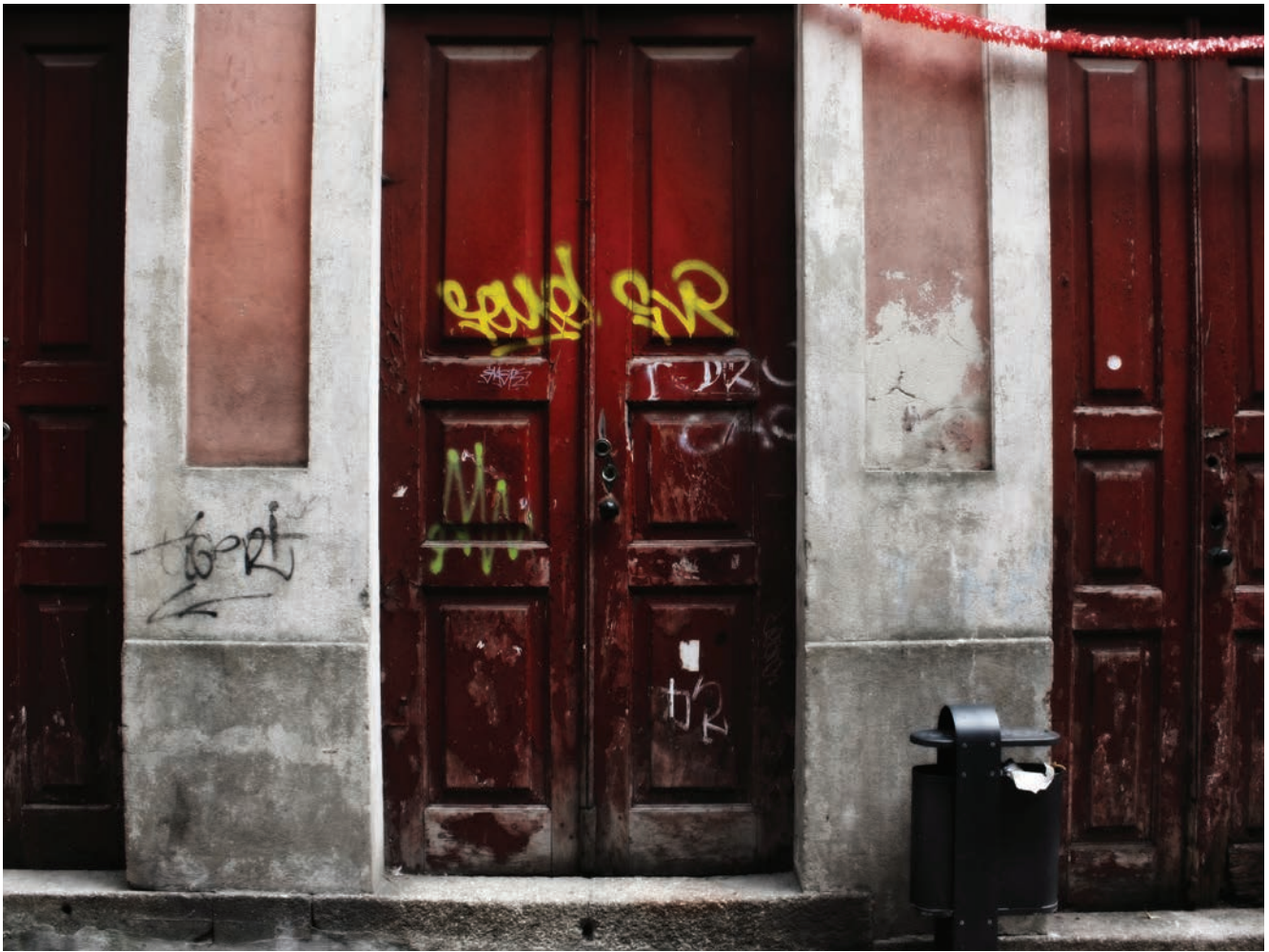
Edifício da Rua da Reboleira
