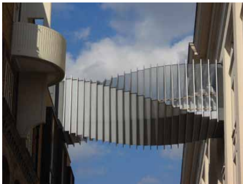
Bridge of Aspiration , a ponte que liga os edifícios da Royal Ballet School e da Royal Opera House, em Londres.
