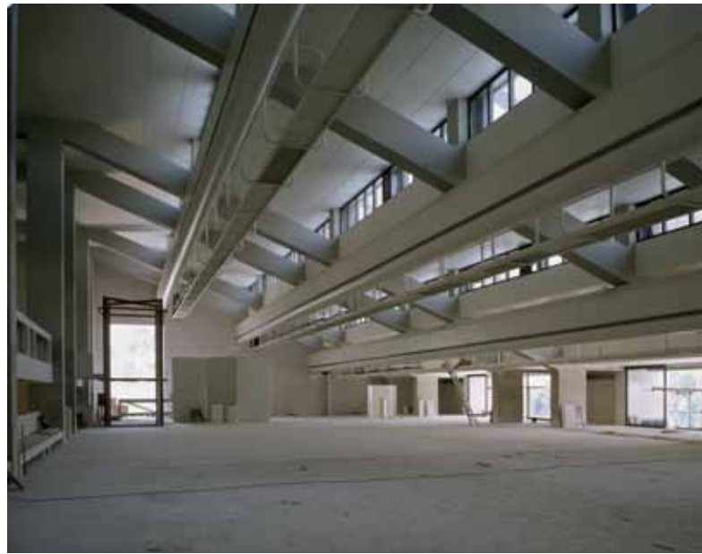
Interior do CAM em fase de construção
