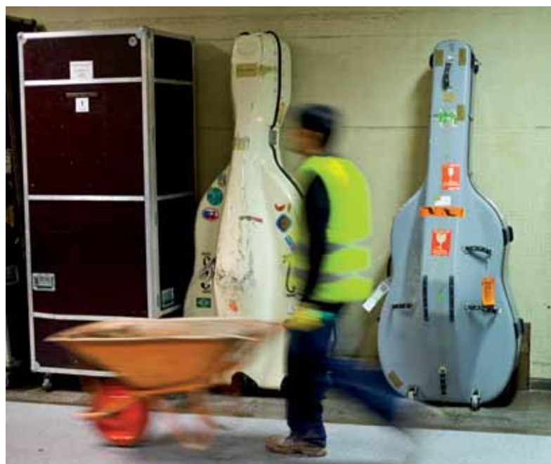
Início das obras de remodelação do Grande Auditório © Márcia Lessa
