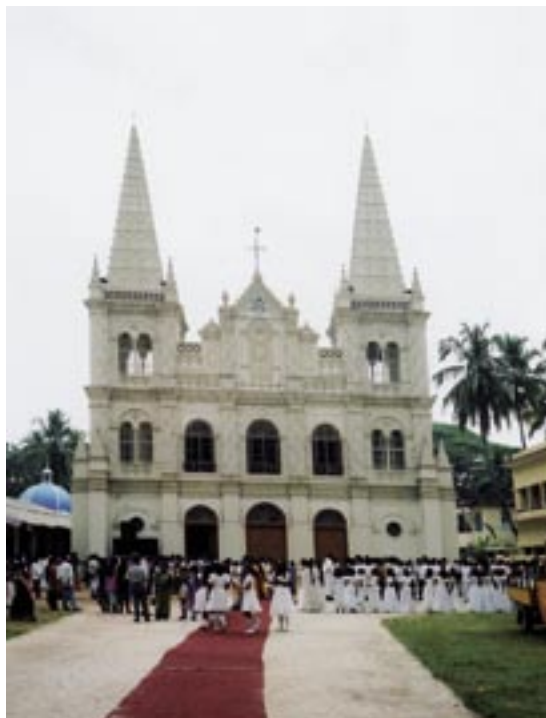
Aspecto da fachada da Basílica de Santa Cruz, Cochim, Índia, após trabalhos de restauro apoiados pela Fundação Calouste Gulbenkian.
