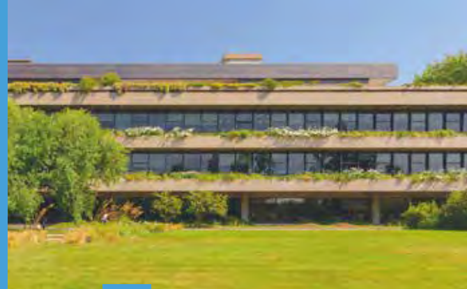
Fachada do Edifício Sede. © FCG / Ricardo Oliveira Alves
