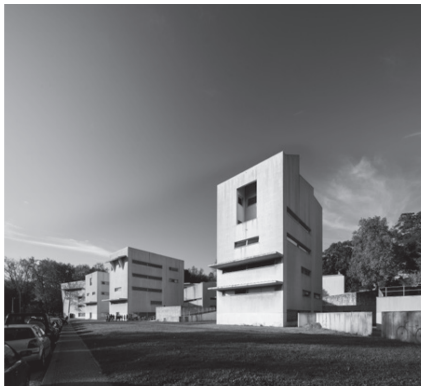
Faculdade de Arquitetura da Universidade do Porto / Faculty of Architecture, University of Porto, Porto, 1979-97
