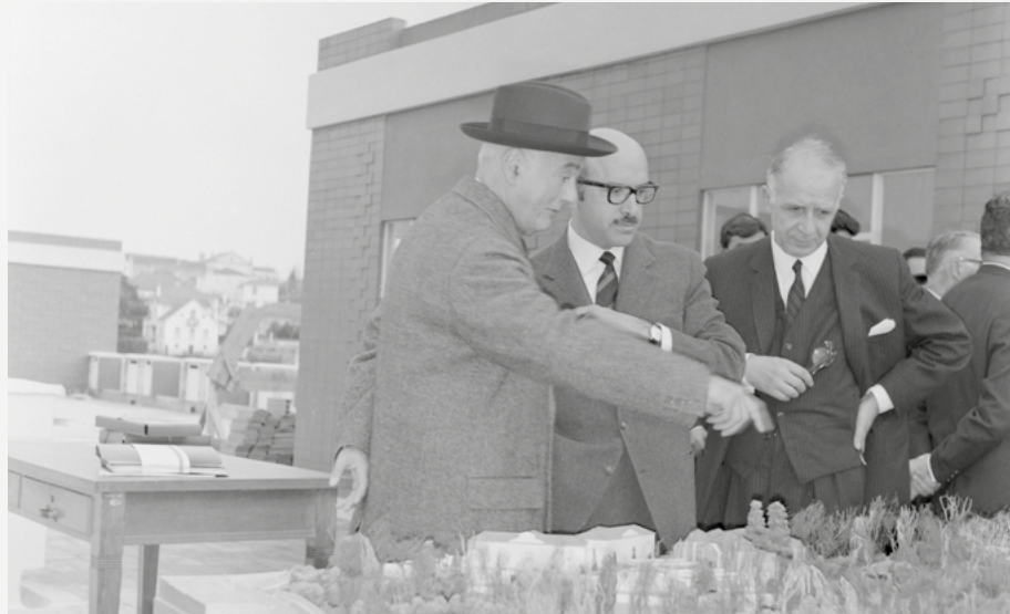
Percurso no terraço do Centro de Biologia e observação de maquete. 1967 © Fundação Calouste Gulbenkian. Serviço de Projectos e Obras. Coleção fotográfica
